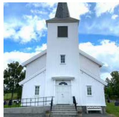
Det nye inngangspartiet med tilbygg.
